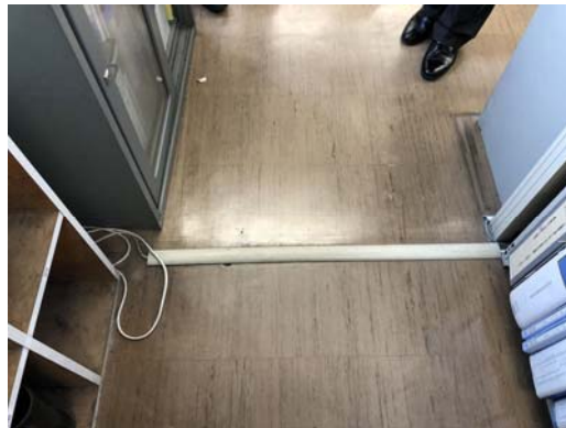
配線カバー（配線モール）の突出
